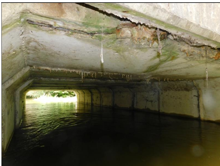
Silné zatékání mezi římsou a krajním prefabrikátem na pravé straně.
