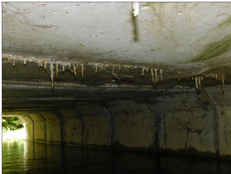
Silné průsaky s výluhy a inkrustacemi ve spáře mezi krajními dvěma prefabrikáty na pravé straně.
