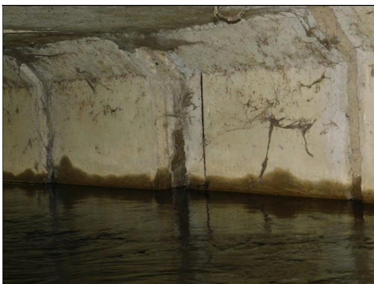
Líc stěny prefabrikátu u opěry OP2 - obnažená korodující výztuž.
