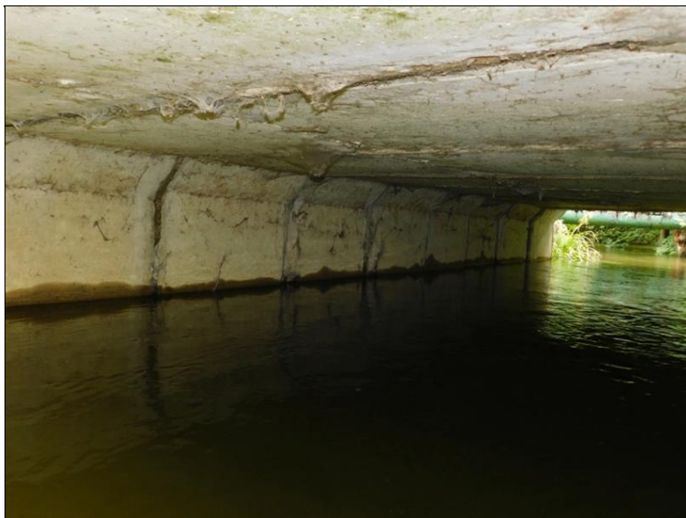
Pohled na stěnu prefabrikátů u opěry OP2.
