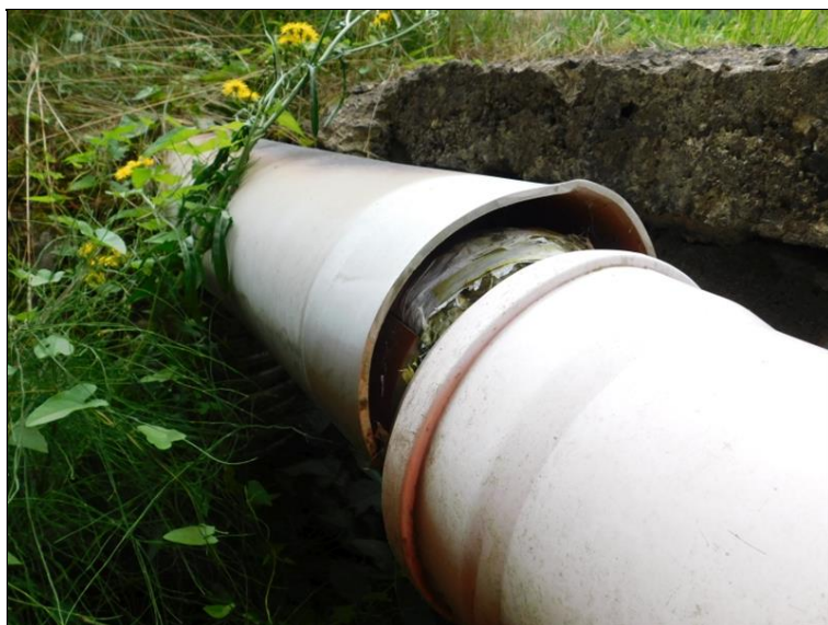
Rozpojená plastová chránička na pravé straně mostu.
