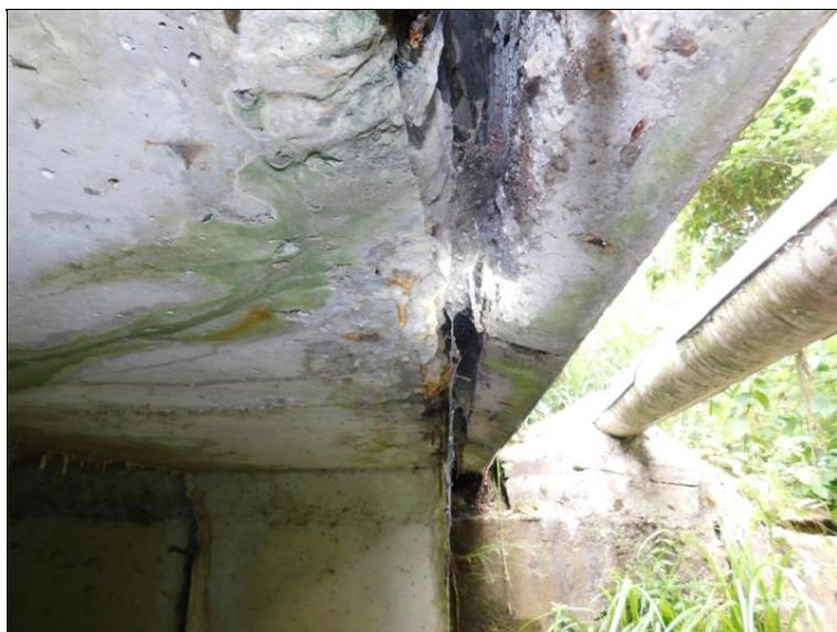
Detail spáry mezi krajním segmentem a římsou - silné průsaky.
