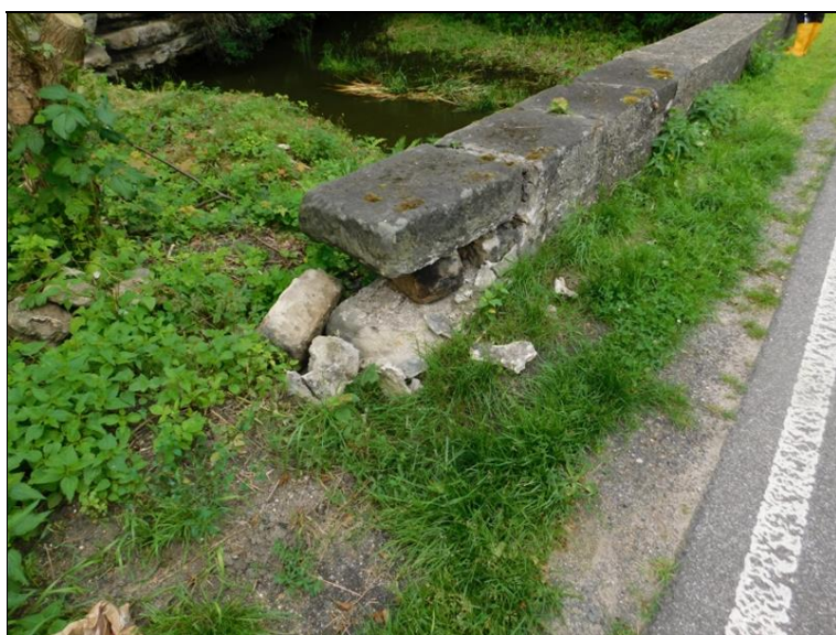
Poškozený / rozpadlý konec kamenné parapetní zídky.
