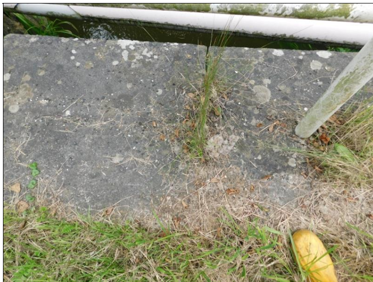
V příčné spáře v římse je uchycená vegetace.
